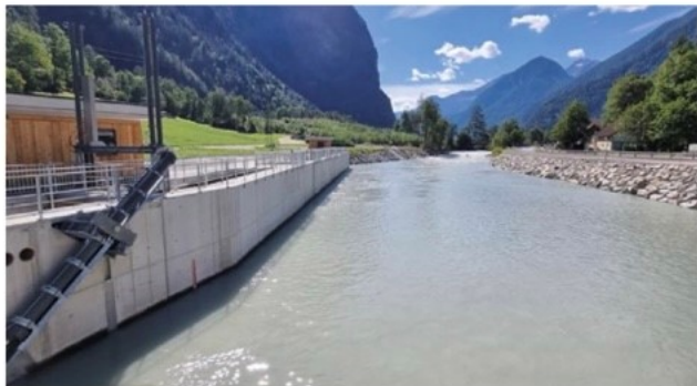
Das Wasserkraftwerk Tumpen-Habichen im Ötztal nutzt die Gefällestufe der Ötztaler Ache.
